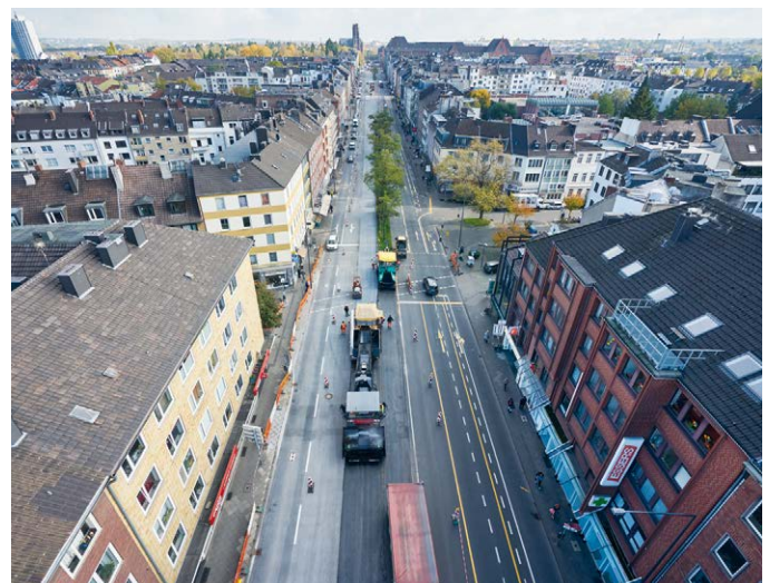
Bild 3: CIAir® Asphalt Maßnahme in Aachen
